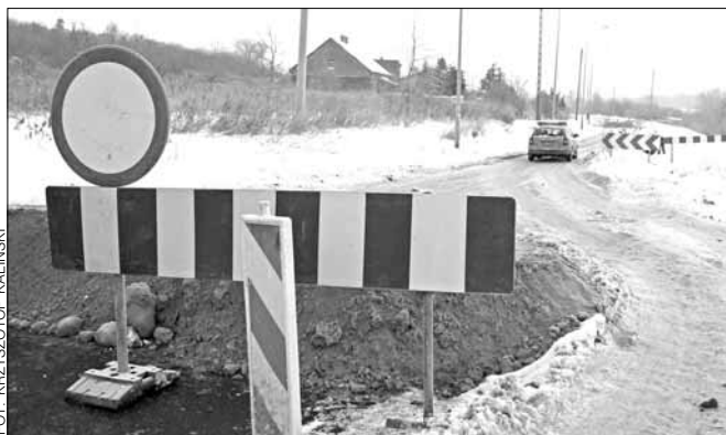
Ul. Grabówka czeka gruntowna przebudowa
