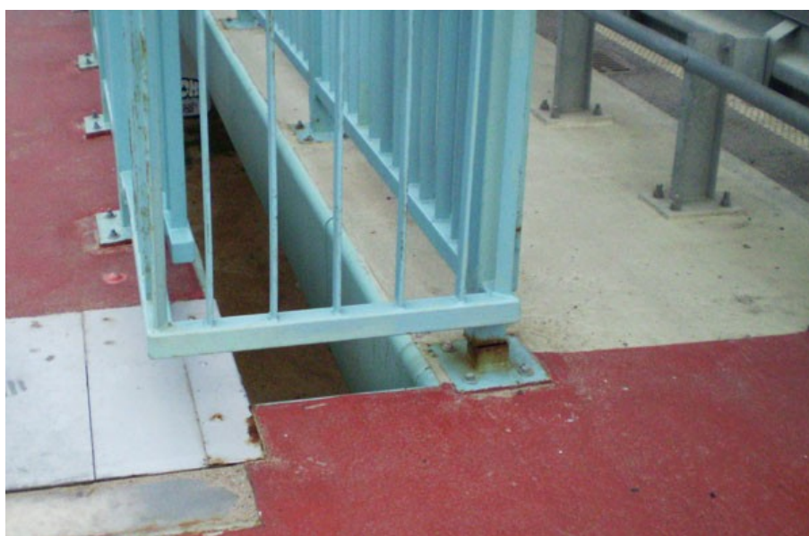
Fotografia 47. Grubość betonowej płyty wierzchniej wiaduktu umożliwia dokręcenie konstrukcji pomostu poszerzającego do jej boku
