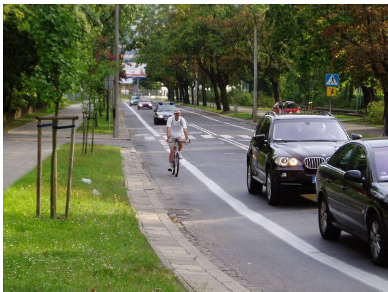
Fotografia 11. Pas „filtrujący” ruch rowerowy przed skrzyżowaniem (Lipsk)
