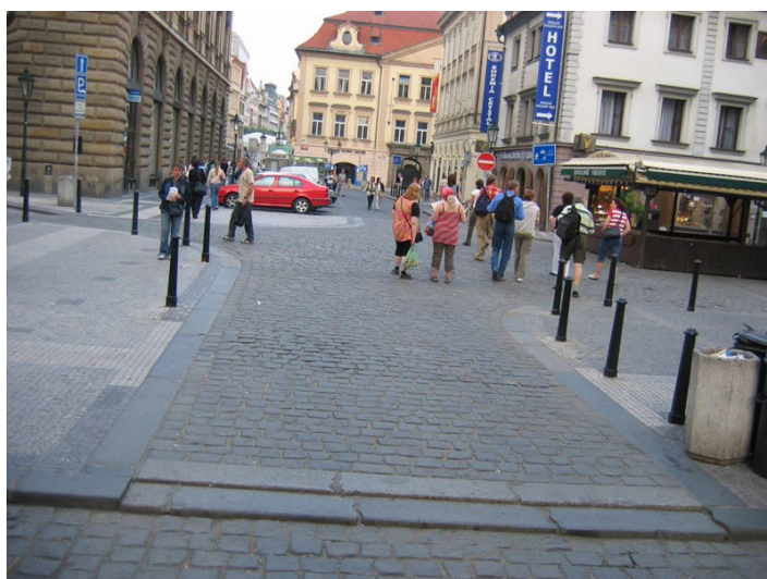
Fotografia 26. Wyniesiona tarcza skrzyżowania, w dodatku z progami o przekroju schodkowym (Praha)
