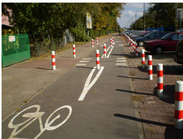
Fotografia 42. Warszawa, ul. Podleśna – prawidłowe rozmieszczenie i oznakowanie słupków przeciw wjeżdżaniu samochodów – słupek zawsze powinien być umieszczony pośrodku szerokości ścieżki rowerowej, aby umożliwić minięcie się rowerzystów nadjeżdżających z przeciwnych stron
