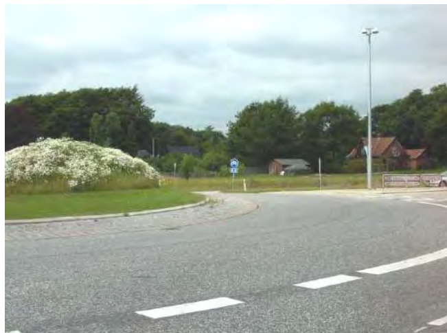
Rys.10.14. Rondo, jako metoda redukcji hałasu drogowego ( http://www.silence-ip.org/site/fileadmin/SP H/SILENCE H .D1 20070105 DRI Final.pdf )
