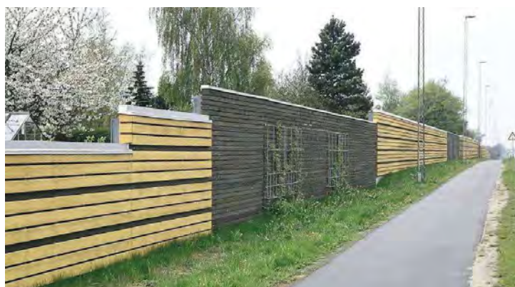
Rys. 10.16. Ekran przeciwhałasowy (cegła, drewno)
