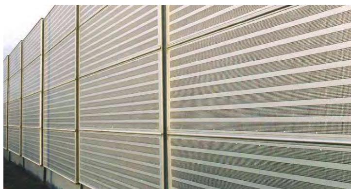
Rys. 10.18. Ekran przeciwhałasowy (dźwiękochłonny)
