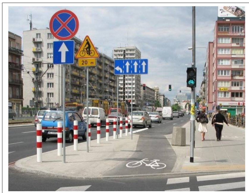
Fotografia 13. Włączenie jednokierunkowej drogi dla rowerów w jezdnię – w dodatkowy pas ruchu (Warszawa, ul. Puławska).
