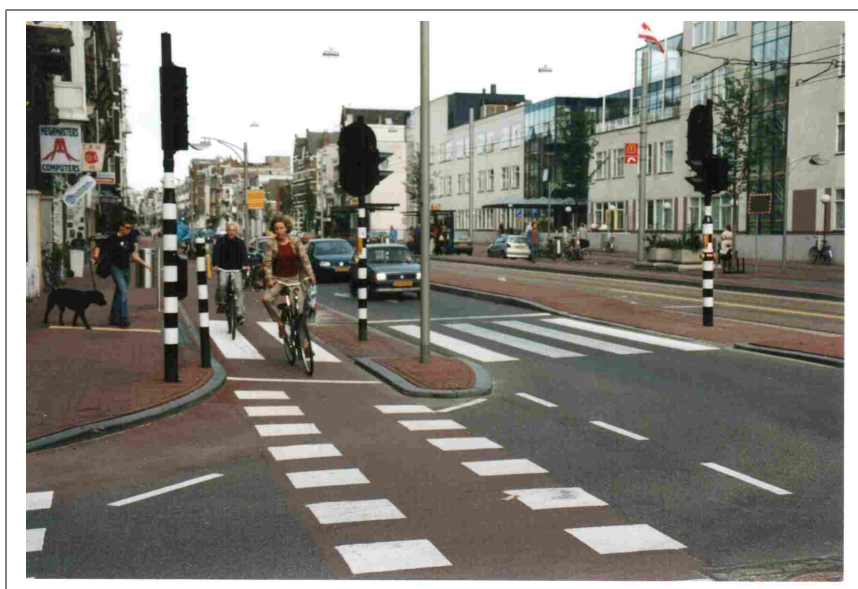
Fotografia 18. Prawidłowe przeprowadzenie jednokierunkowej drogi dla rowerów przez skrzyżowanie - zintegrowane z jezdnią, zwraca także uwagę mały promień łuków skrzyżowania (Amsterdam)
