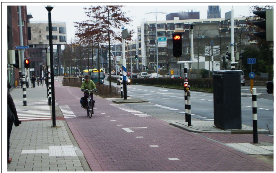
Fotografia 12. Przykład skrzyżowania projektowanego bez łuków (Amersfoort, Holandia)
