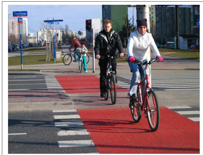
Fotografia 7. Zaleca się, aby części jezdni przeznaczone dla ruchu rowerów pokryte były emulsją barwy czerwonej (Warszawa, Ursynów)
