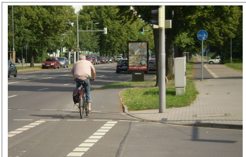
Fotografia 18. Prawidłowe przeprowadzenie jednokierunkowej drogi dla rowerów przez skrzyżowanie - zintegrowane z jezdnią, zwraca także uwagę mały promień łuków skrzyżowania (Amsterdam)
