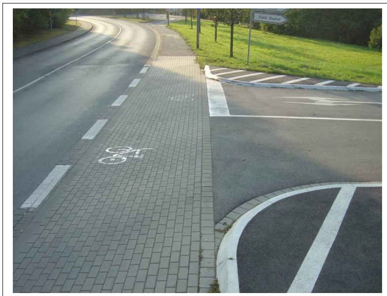
Fotografia 11. Przykład korekty skrzyżowania w celu zmniejszenia promieni łuków i prędkości skręcających samochodów, nawierzchnia ścieżki rowerowej pozostaje ciągła, odcinając przecznice (Niemcy, Örlinghausen w Westfalii)
