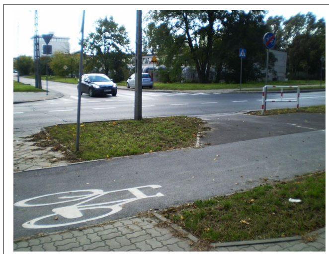
Fotografia 23. Przykład połączenia drogi dla rowerów ze skrzyżowaniem na zasadzie kolejnego jego ramienia (Warszawa, ul. Podleśna)
