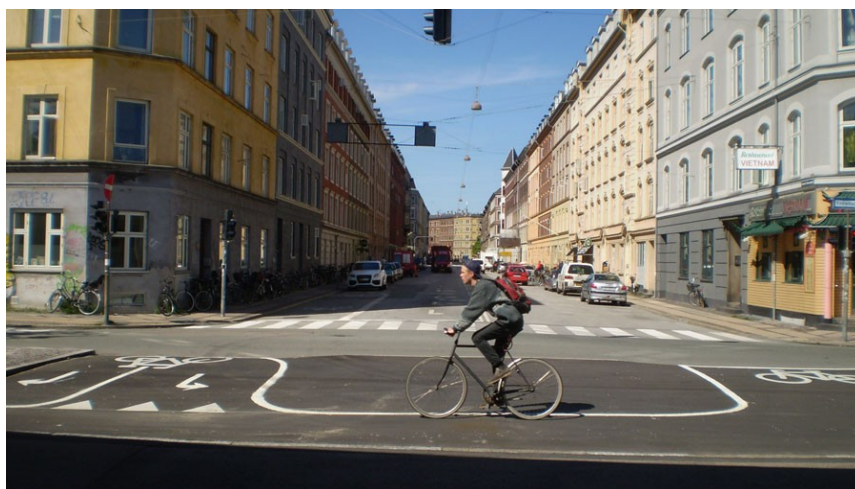
Fotografia 22. Przykład połączenia drogi dla rowerów ze skrzyżowaniem na zasadzie kolejnego jego ramienia (Kopenhaga)
