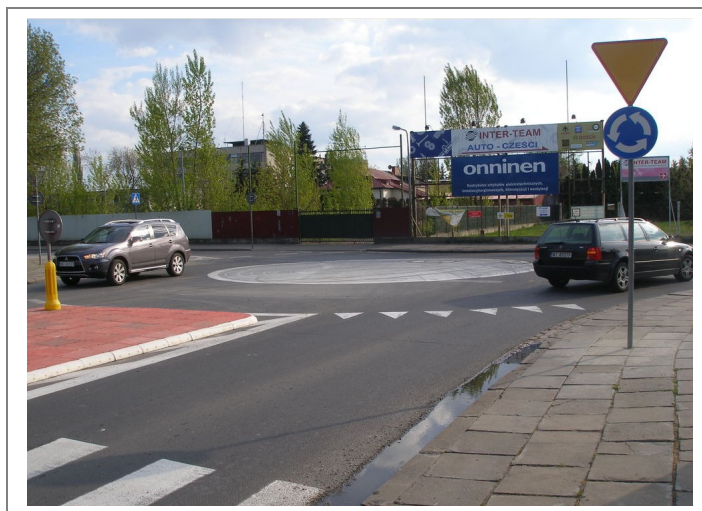
Fotografia 21. Przykład przebudowy skrzyżowania na minirondo za pomocą elementów prefabrykowanych bez konieczności przebudowy nawierzchni i krawężników (Warszawa, ul. Kowalczyka / Klembowskiej)
