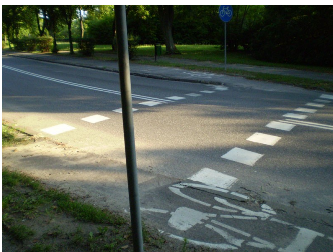
Fotografia 8. Drogi dla rowerów w ul. Mostowej
